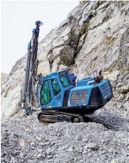
Sprenglöcher bohren mit dem Strossenbohrgerät
