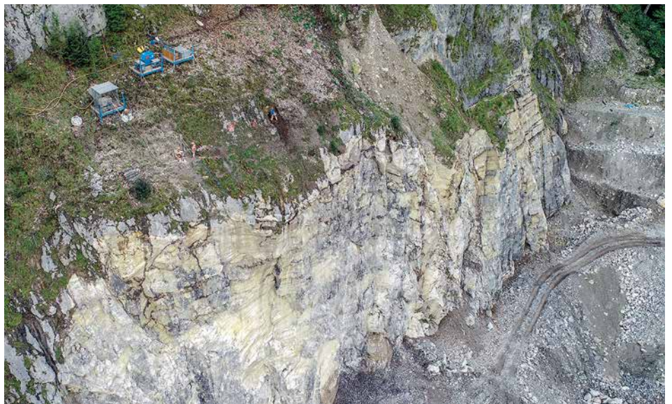
Bohrarbeiten oberhalb des geplanten Abtrages
