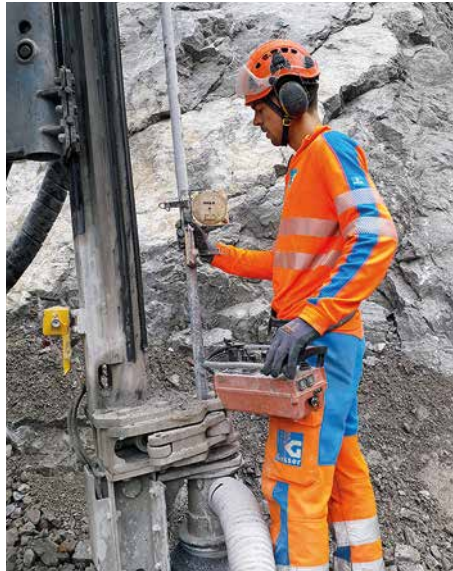
Ausrichtung Bohrlafette mit Neigungswaage
