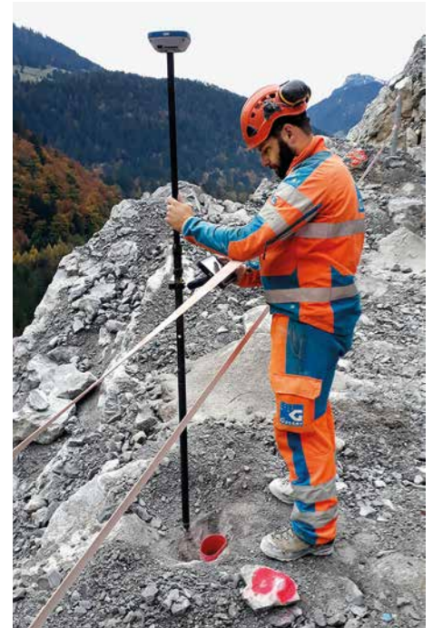
Vermessung Bohrlochansatzpunkt mit GPS-Stock
